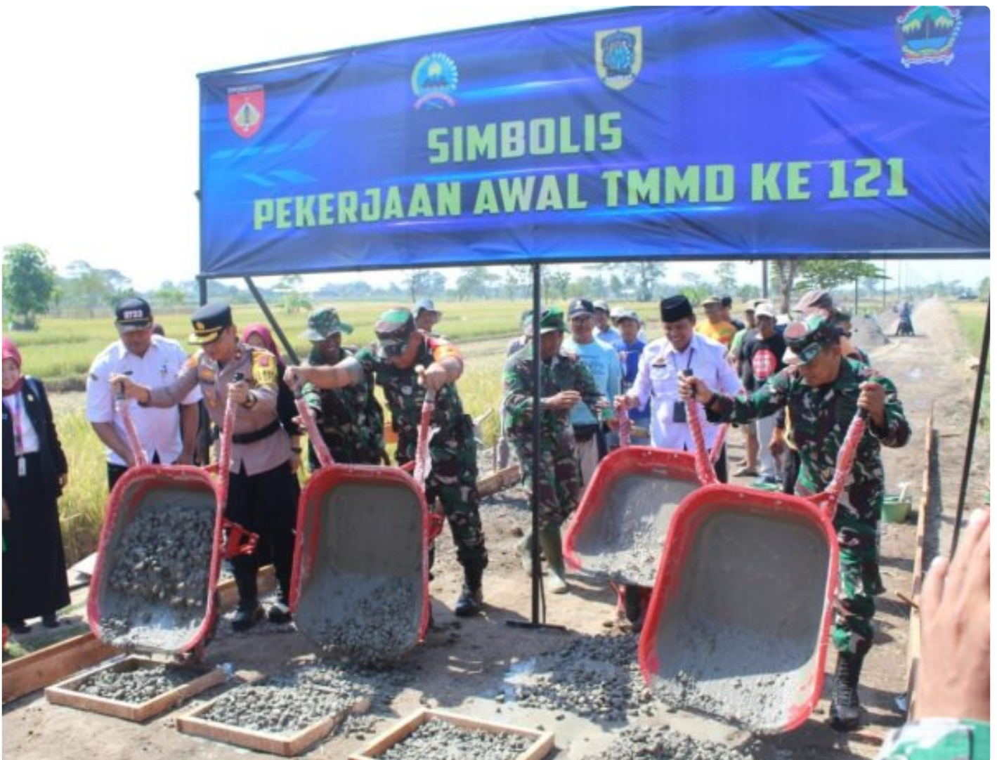
Pengecoran Perdana TMMD Reg 121 dilakukan Forkopimda Klaten
